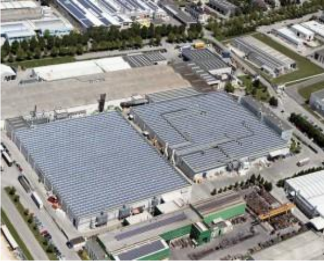
ILCAM stabilimento produttivo, Italia 930 kWp (2011)
